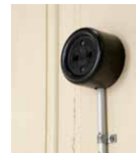
Den nære fortid er også i historie. Det elektriske anlegget er skiftet, men første generasjon brytere og ledninger er bevart
