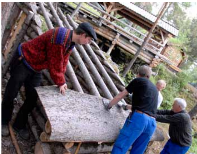
Tekking av gapahytte med granbark i Bygningshistorisk park. Tradisjonsberar er Oddbjørn Myrdahl frå Gran på Hadeland
